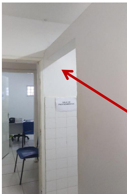
Figura 1- Viga a ser reforçada com apoio de pilar
