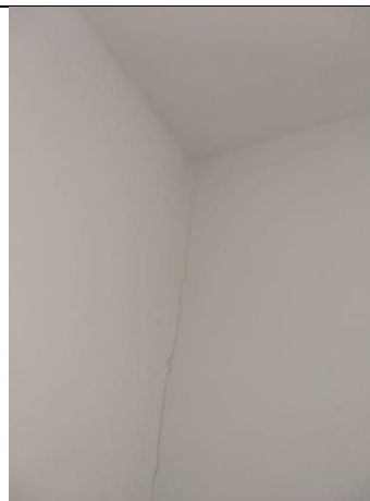
Trinca a ser tratada
